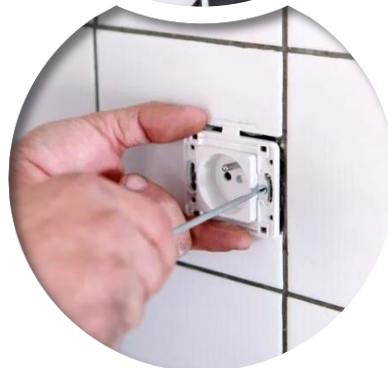
Монтаж/замена элементов электрических сетей
