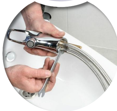
Монтаж/замена элементов канализации/ водоснабжения
