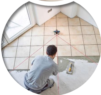
Укладка напольного покрытия, поклейка обоев
