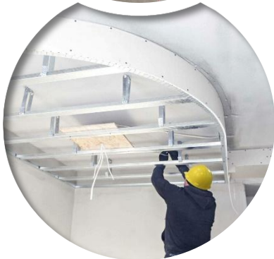
Установка натяжных или подвесных потолков
