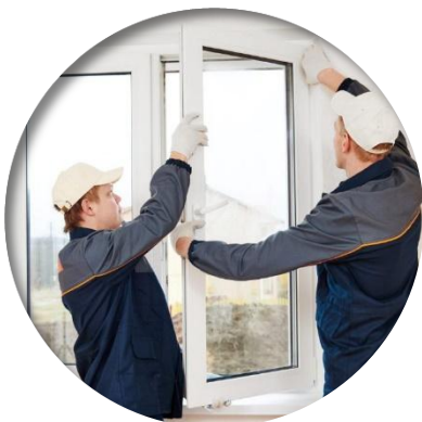
Замена окон и дверей
